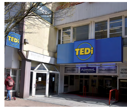
- Unproportionierte und mit Signalfarben ausgeführte Kragplatten beeinflussen die Fassade.
