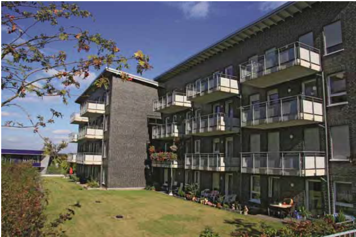
Abbildung 50: Seniorenwohnanlage In den Birken, der Baugenossenschaft Niederberg eG
