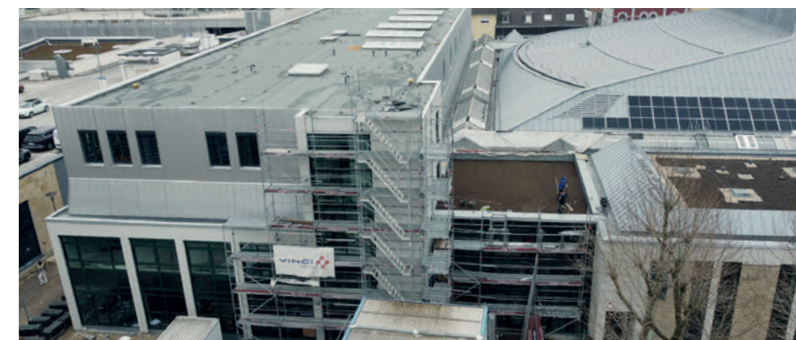
(Bild zum Zeitpunkt des Umbaus, 2023)
